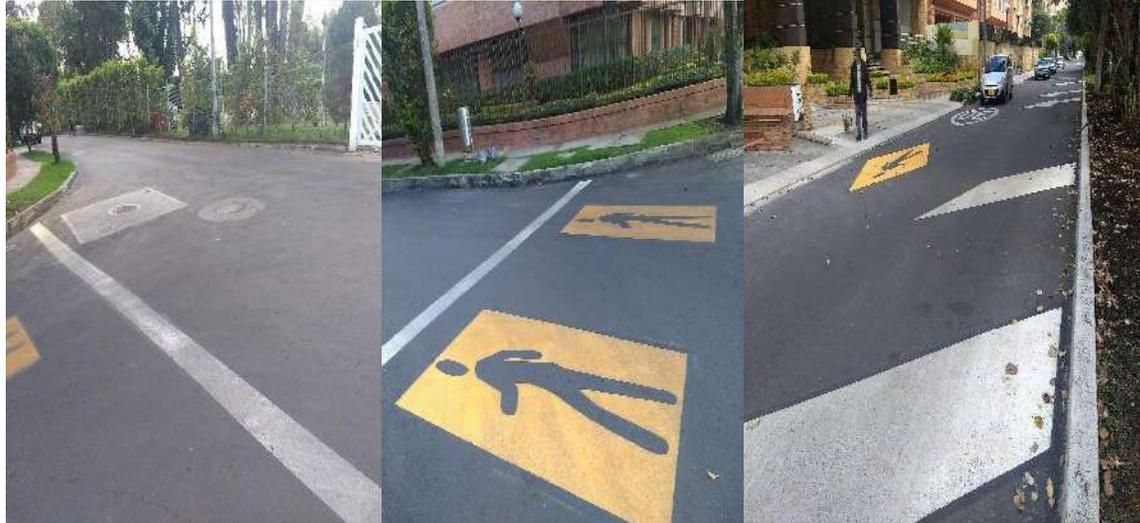
**Observación:** CIV con demarcación vial parcial. Se evidencia diferencia en la tonalidad del color amarillo implementado.
