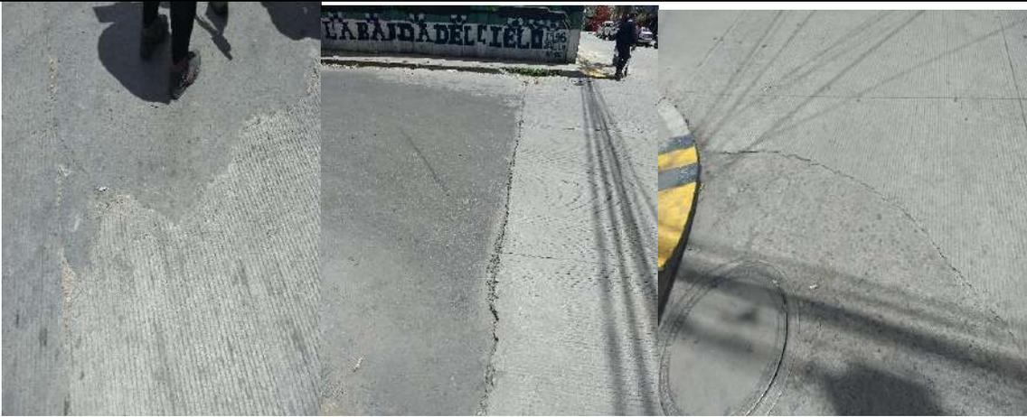
**Observación:** Deficiencia empalme de las losas nuevas y las existentes. Deficiencia en el sello de juntas. Ausencia de sello de juntas. Carencia de confinamiento. Texturizado irregular.
