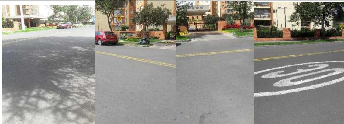
**Observación:** Fisuras en media luna por falla lateral, Hundimiento de calzada. Se identifica parcheo en el empalme sur del CIV. Demarcación vial en regular estado.
