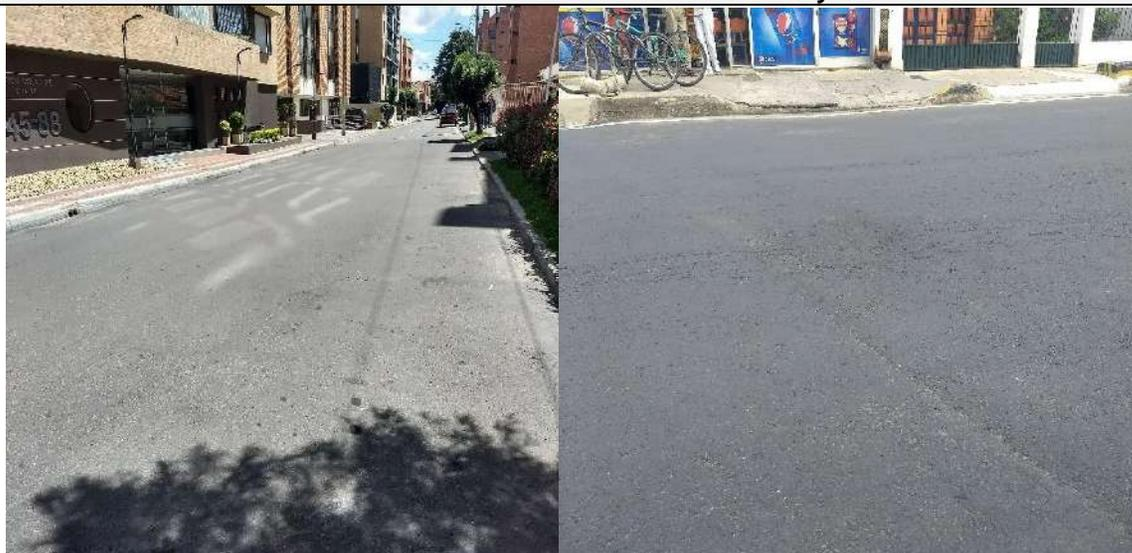
**Observación:** Deficiencia en el empalme entre el pavimento nuevo y el existente.
