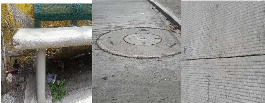
**Observación:** Deterioro prematuro y ausencia de sello de juntas. Fallas en la nivelación de posos. Deficiencia en el empalme entre pavimento nuevo y existente. Texturizado irregular. Fisuras en las placas de los posos de inspección.
